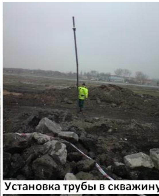
**Установка трубы в скважину**
